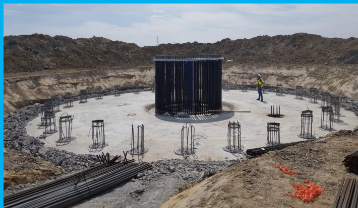
Murowanie fundamentów pod wiatraki w Miłostawiu
